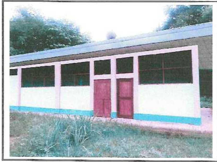
FOTO N° 07, SE MUESTRA FACHADA DEL COLEGIO.
