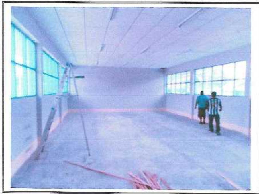
FOTO N° 01, SE MUESTRA PINTADO DE MUROS Y COLUMNAS Y VIGAS, SUM
