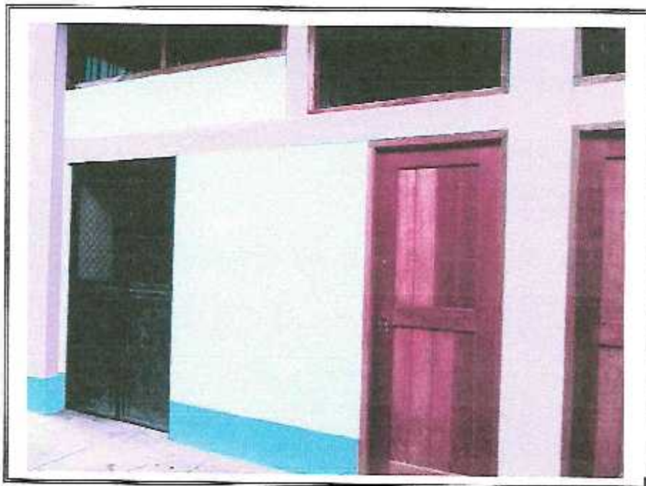
FOTO N° 08, SE MUESTRA ELEVACION POSTERIOR DEL COLEGIO
